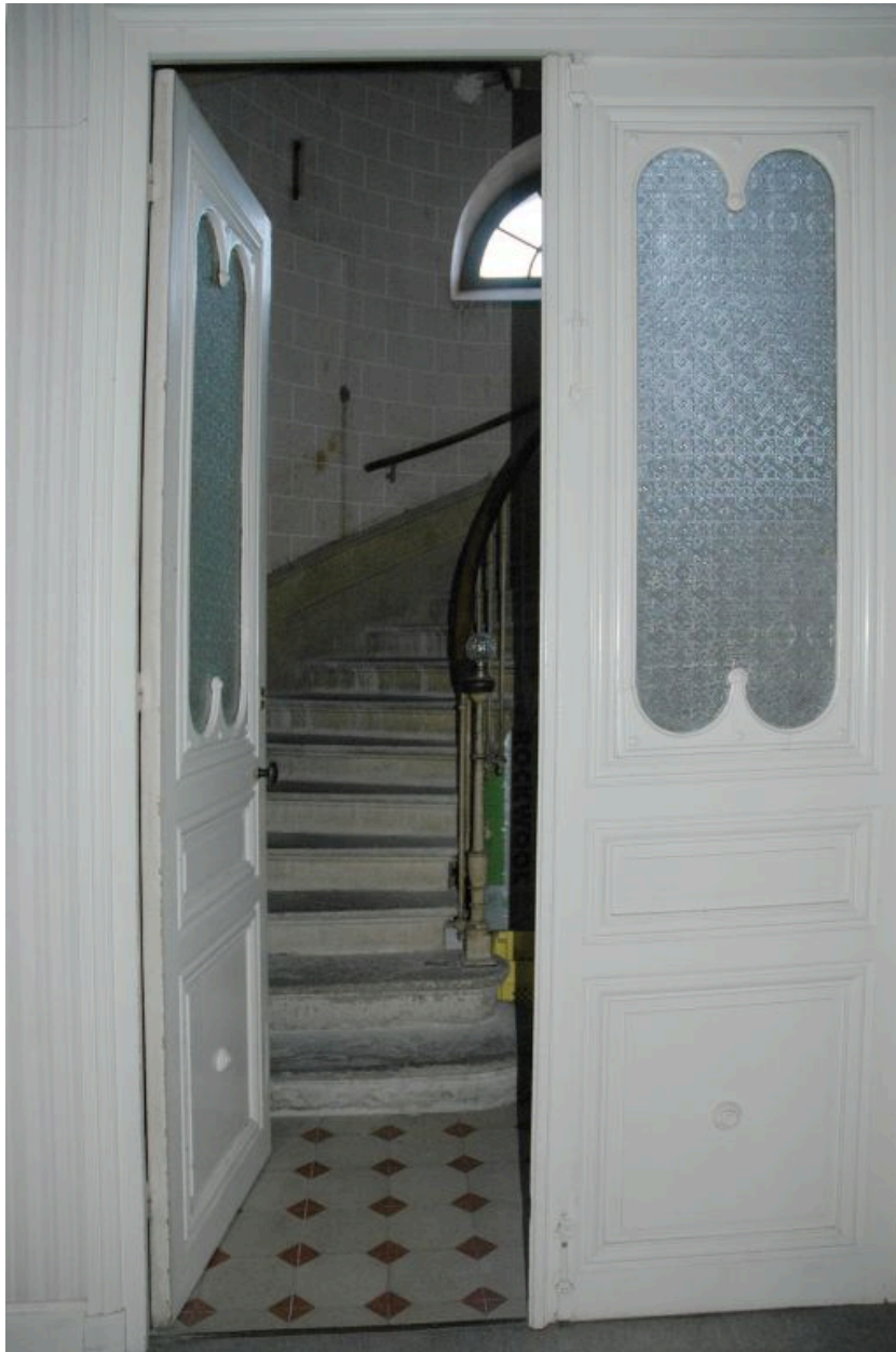
Vue du vestibule d'entrée et du départ de l'escalier.
