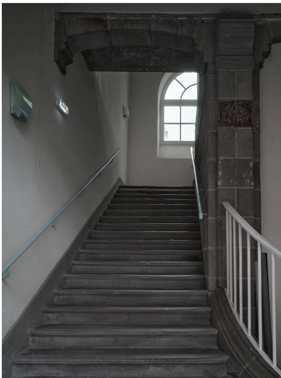
Bâtiment B : escalier B, première volée
