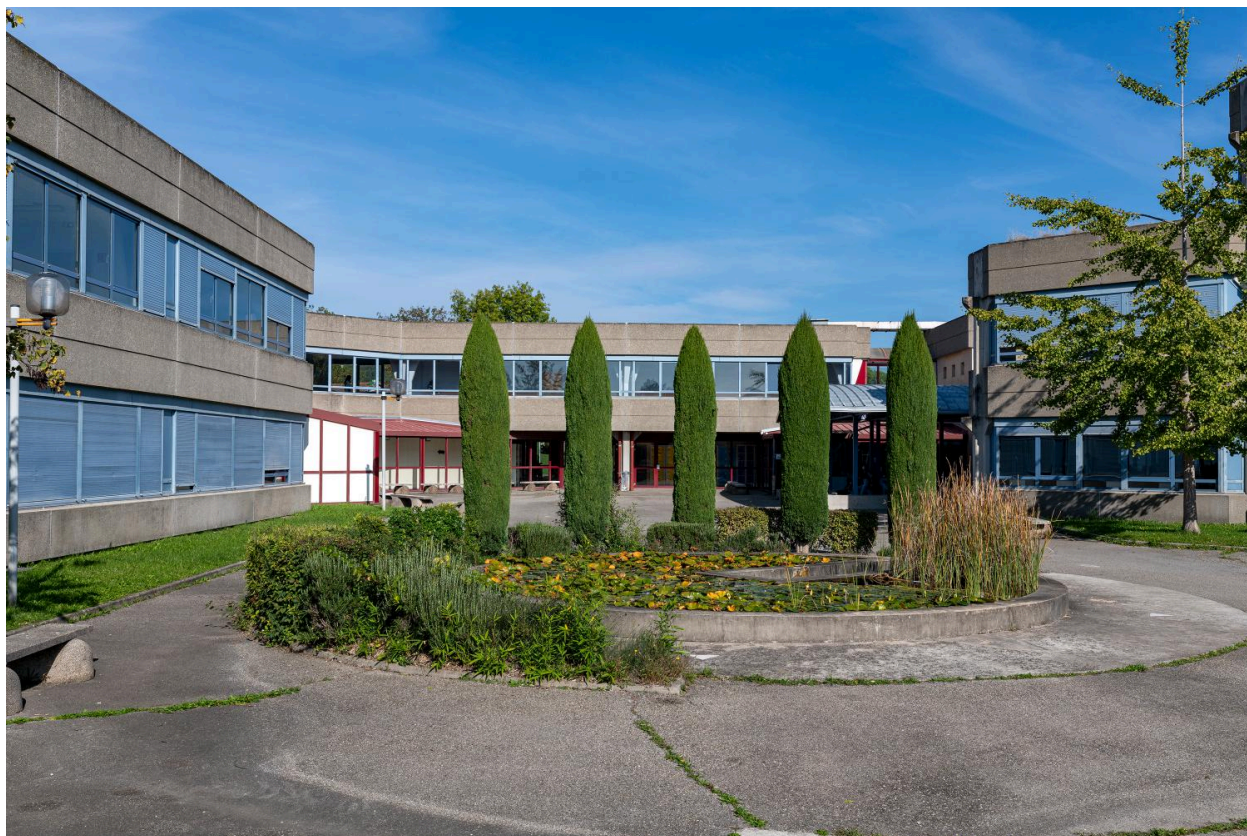
Installation extérieure : autre vue d'ensemble en 2020
