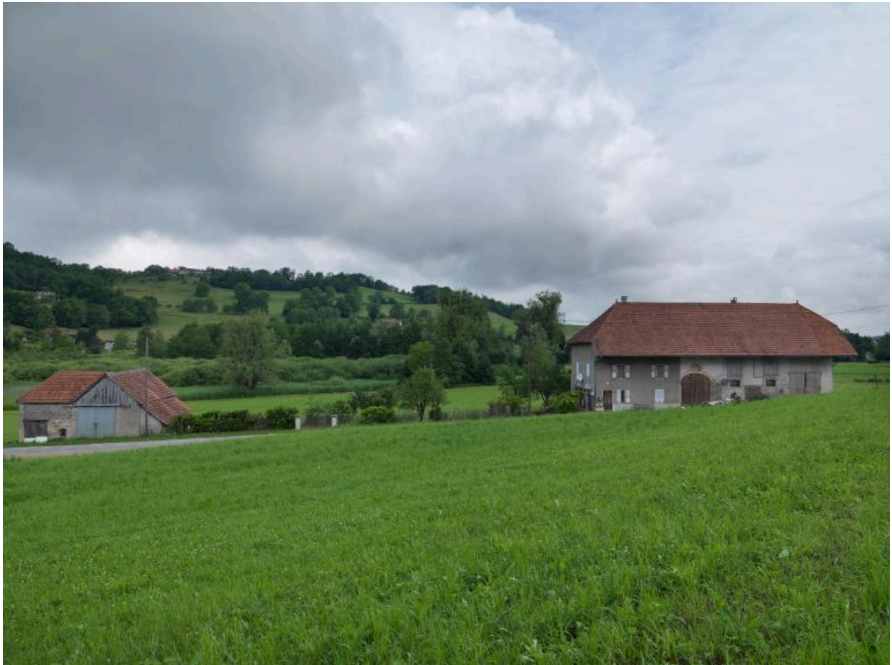
Vue générale du bâtiment le long de la route.
