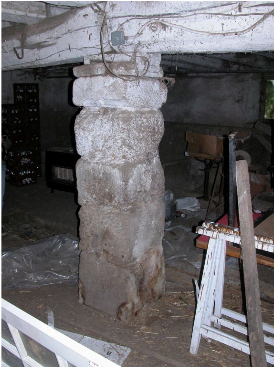
Grange-étable de la ferme du château, détail d'un pilier appareillé de l'étable.
