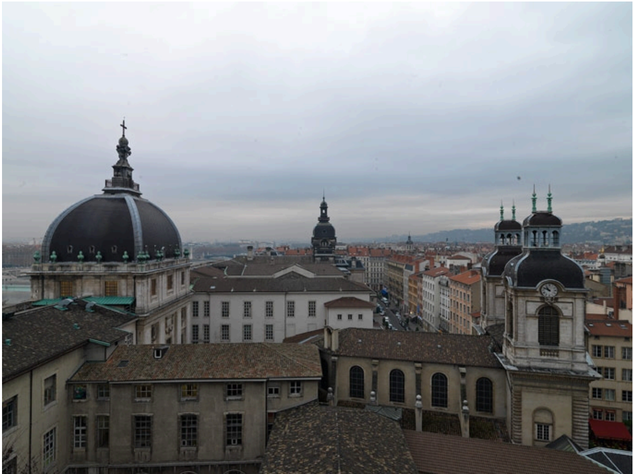
Vue depuis le nord. Le dôme Soufflot, le dôme Pascalon et la chapelle
