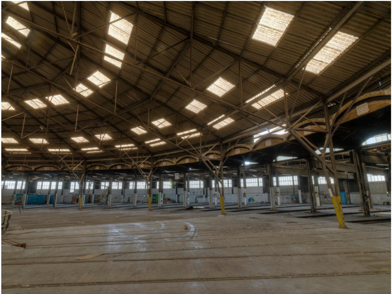
Détail côté rotonde
