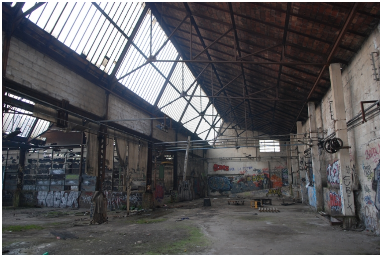
Espace intérieur avec sheds
