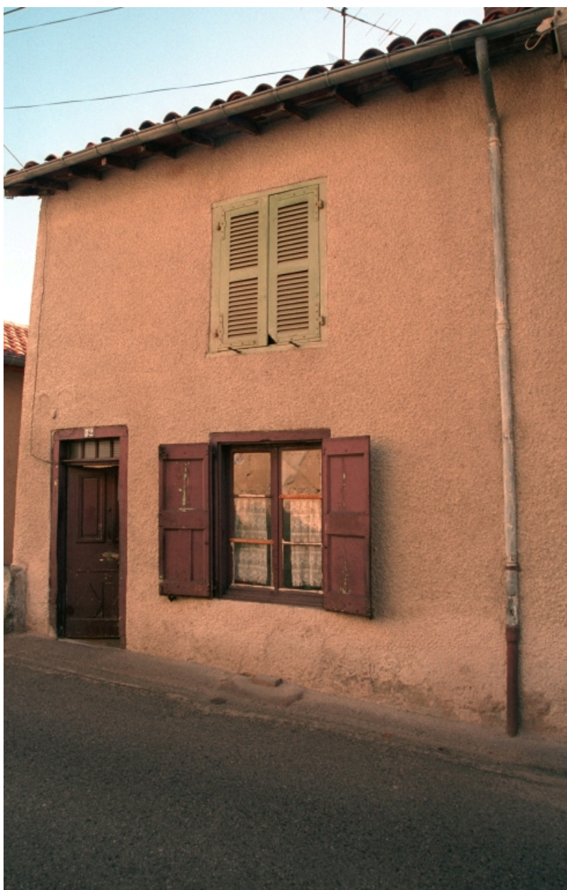
Boën, îlot 13, Ph. Raymond (rue) 32. Vue générale de la façade sur rue.
