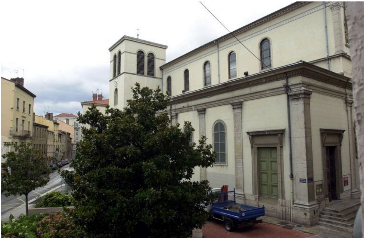
Vue depuis l'ouest
