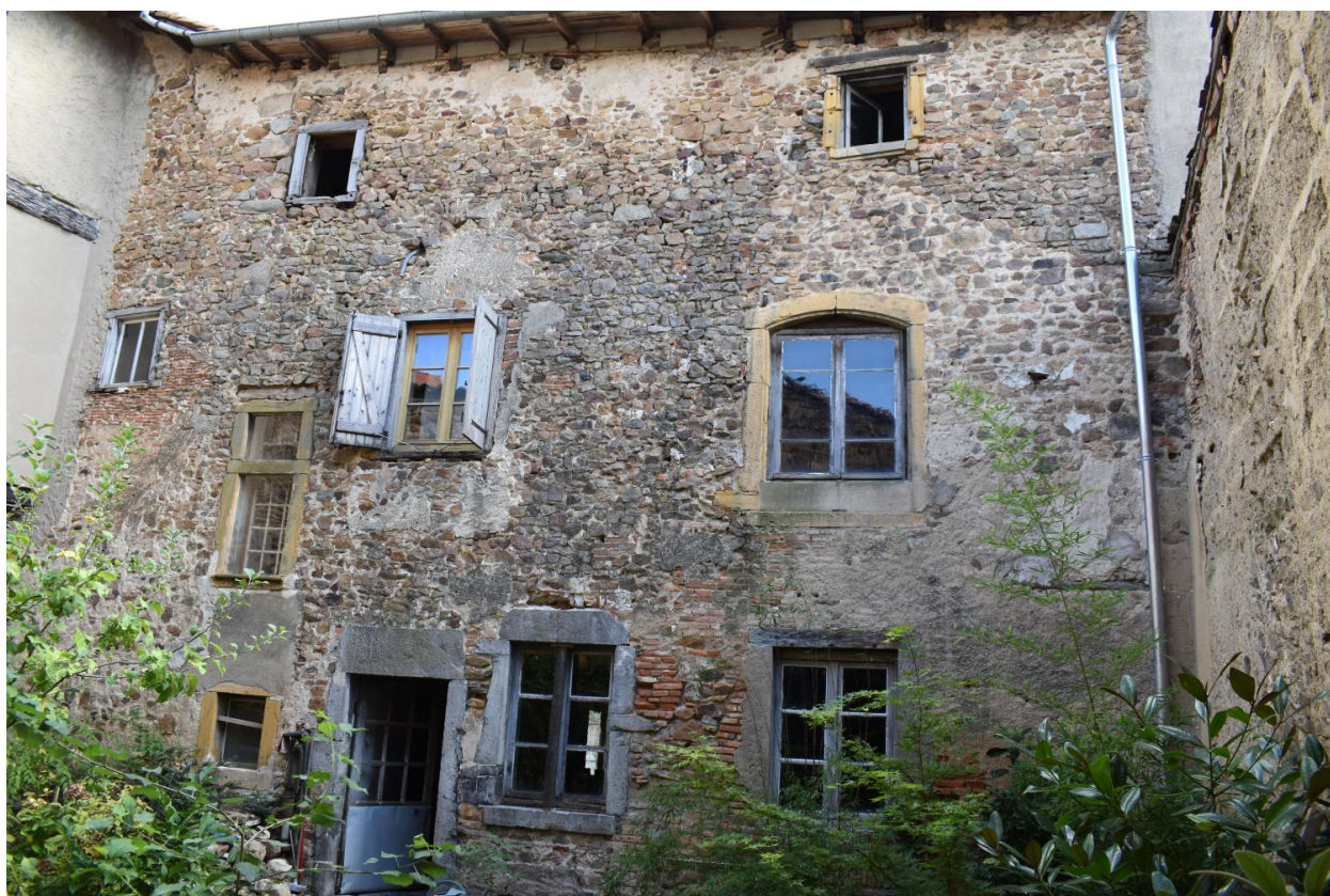
Elévation nord sur cour de la maison, vue d'ensemble.
