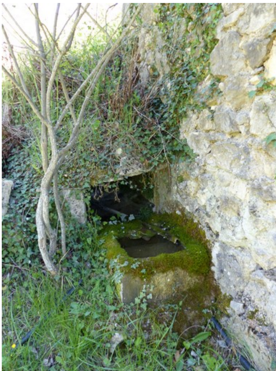
Angle nord-ouest, bassin de décantation et bassin extérieur.
