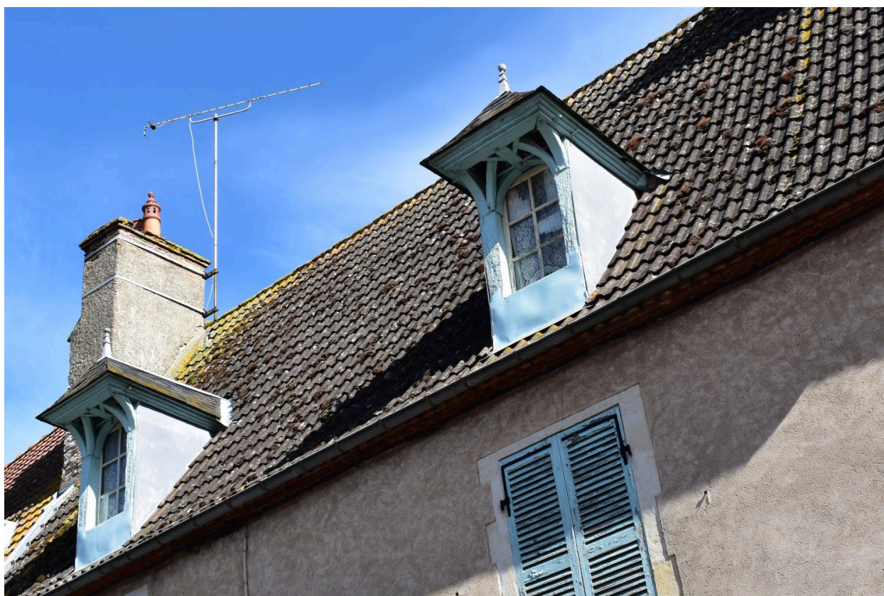
Détail des lucarnes menuisées du n°4 rue d'Allier.
