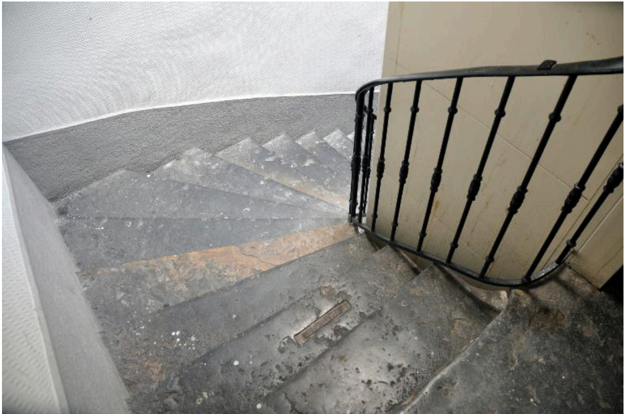
Vue partielle de l'escalier
