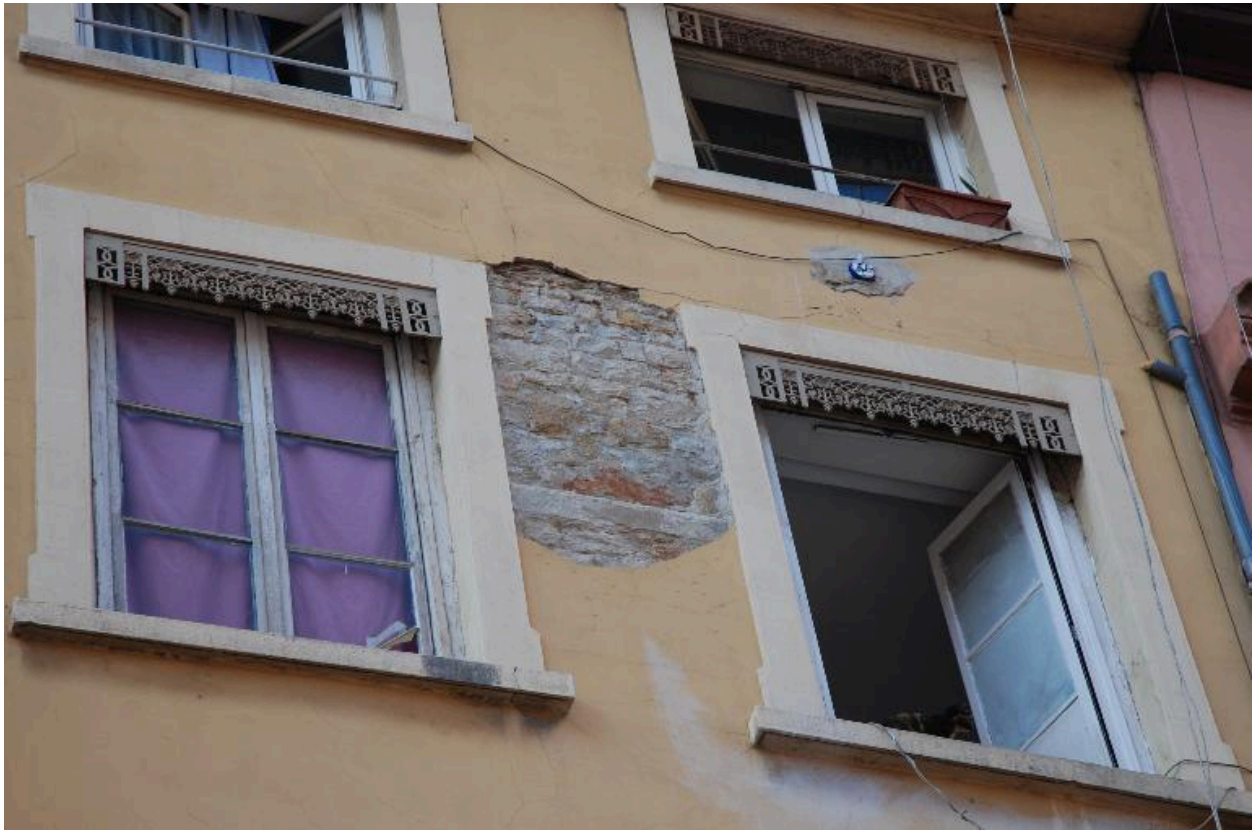
Détail de la façade latérale, rue d'Aguesseau : construction en moellons apparents dans une lacune de l'enduit
