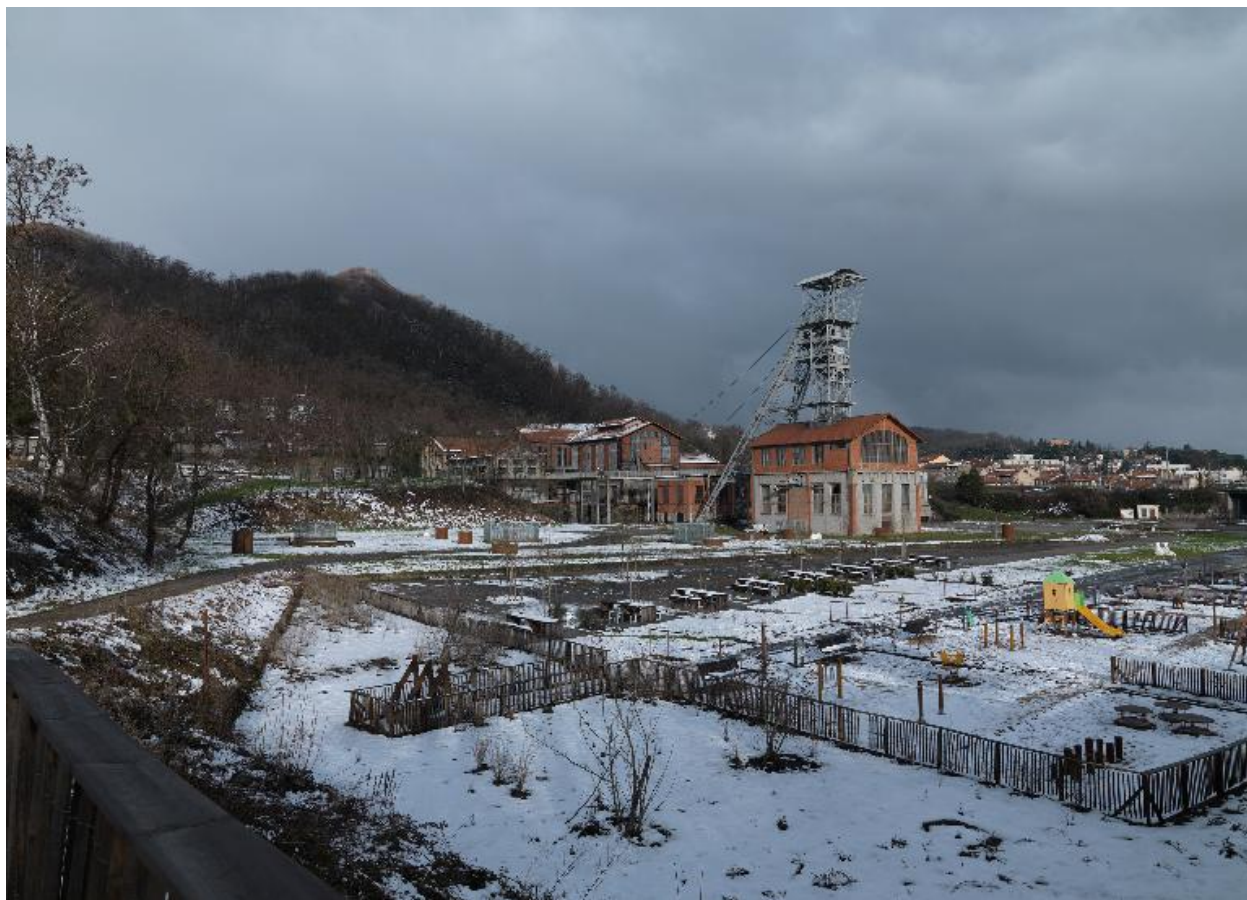
Vue d'ensemble du site de Couriot
