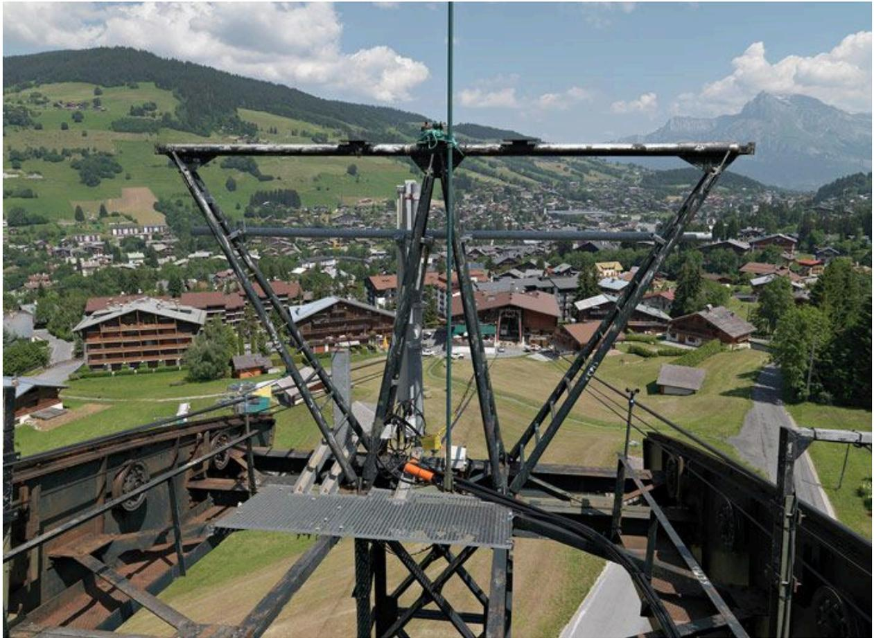
Détail de la tête du pylône et du passage des câbles de part et d'autre
