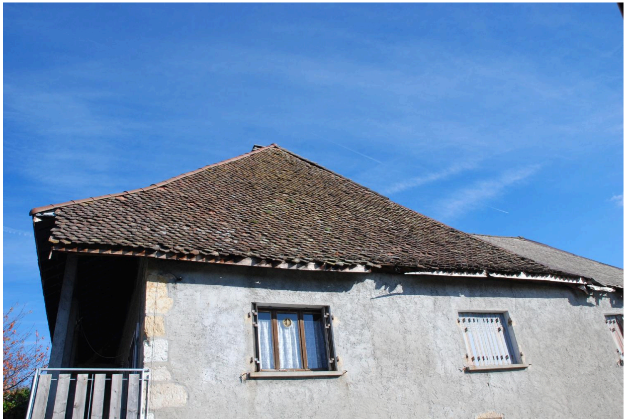
Vue du toit sur l'élévation sud-ouest.
