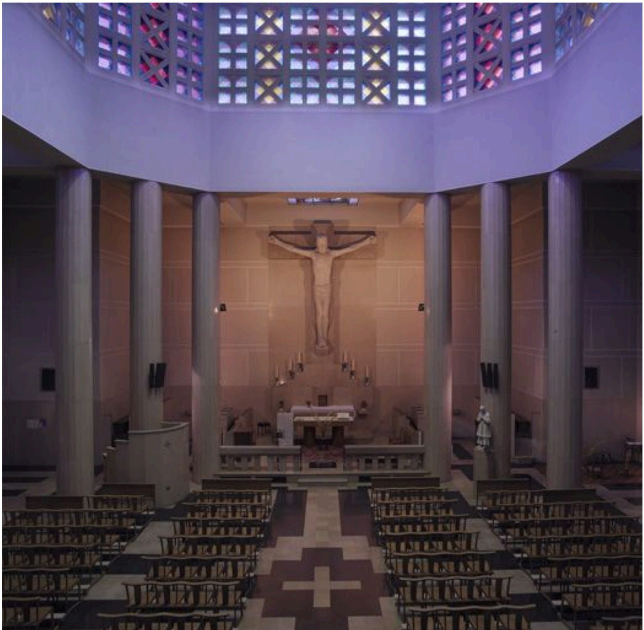
Vue d'ensemble des verrières du tambour
