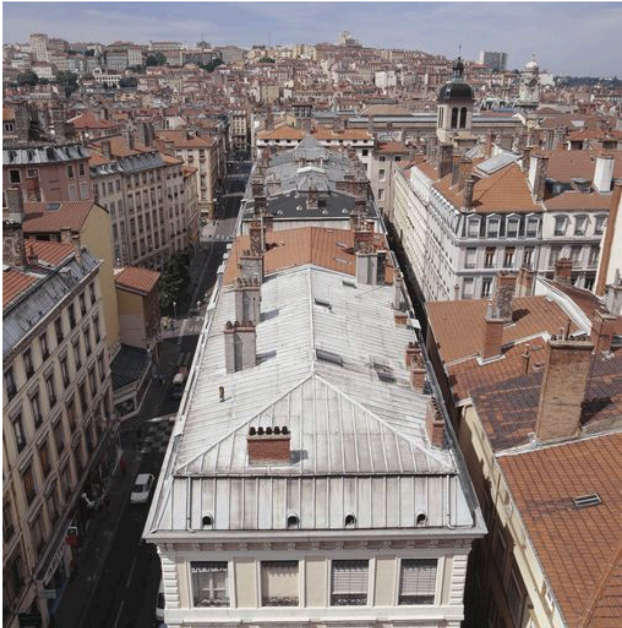
Vue générale du toit
