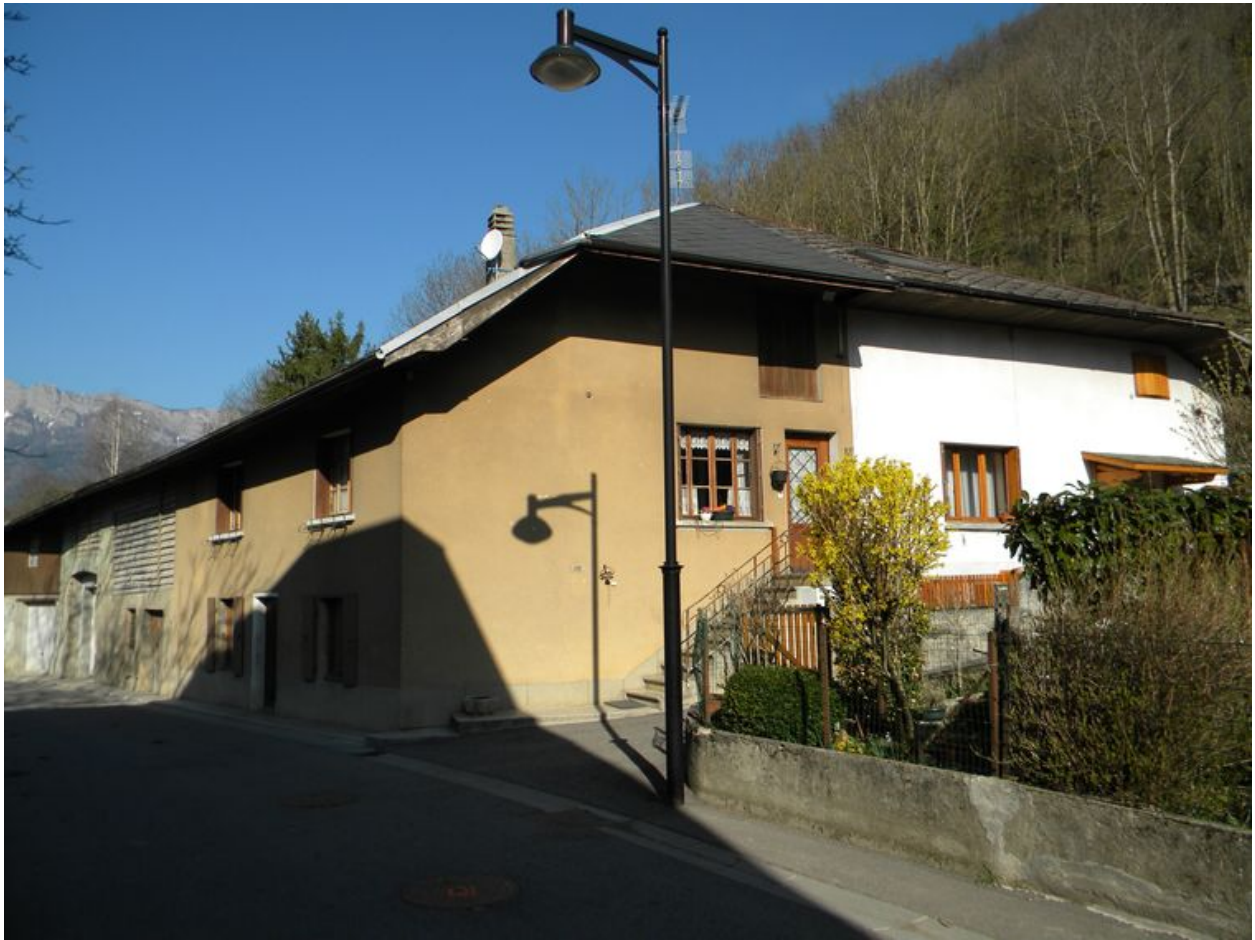
Vue d'un ensemble fermier transformé (A3 2 668)
