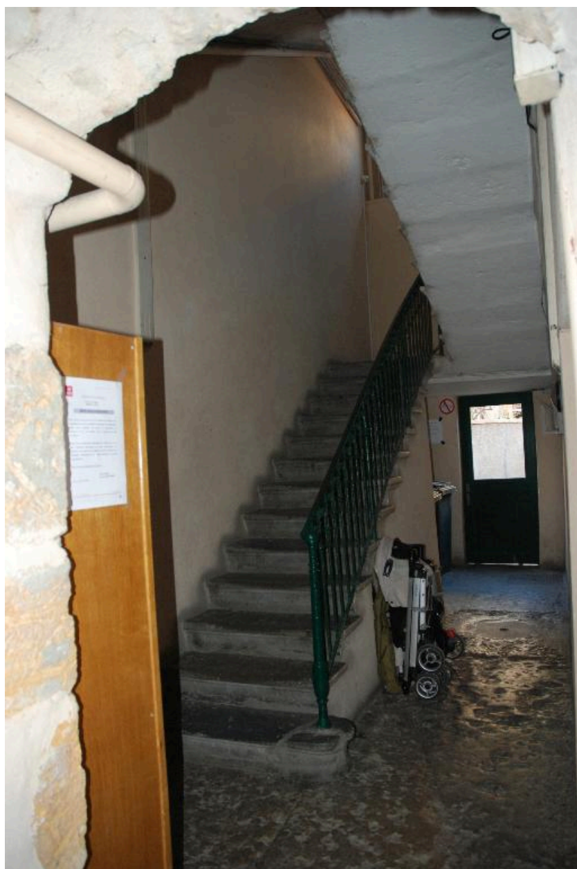
Vue du départ de l'escalier
