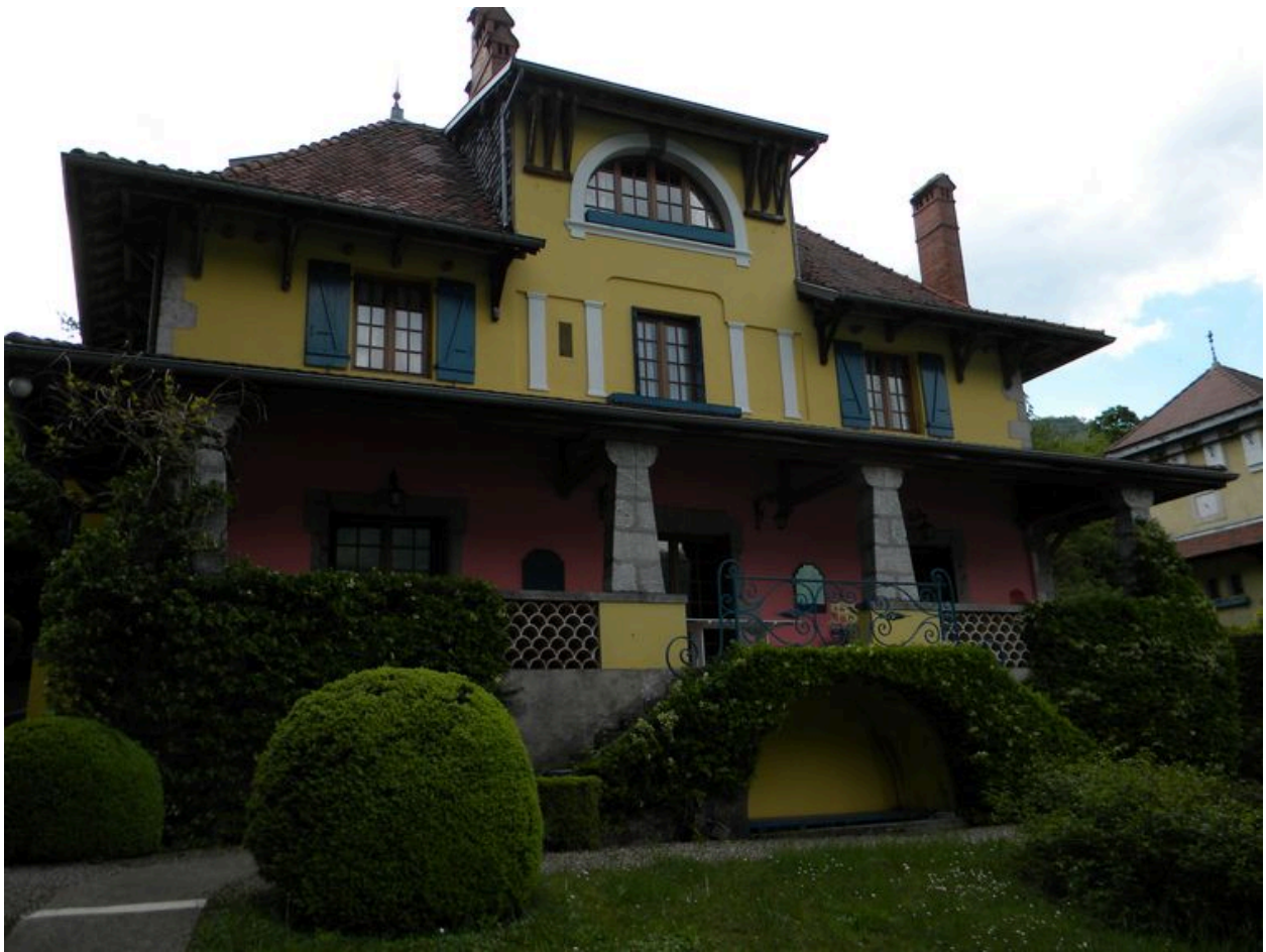
Vue de la façade principale depuis la cour.
