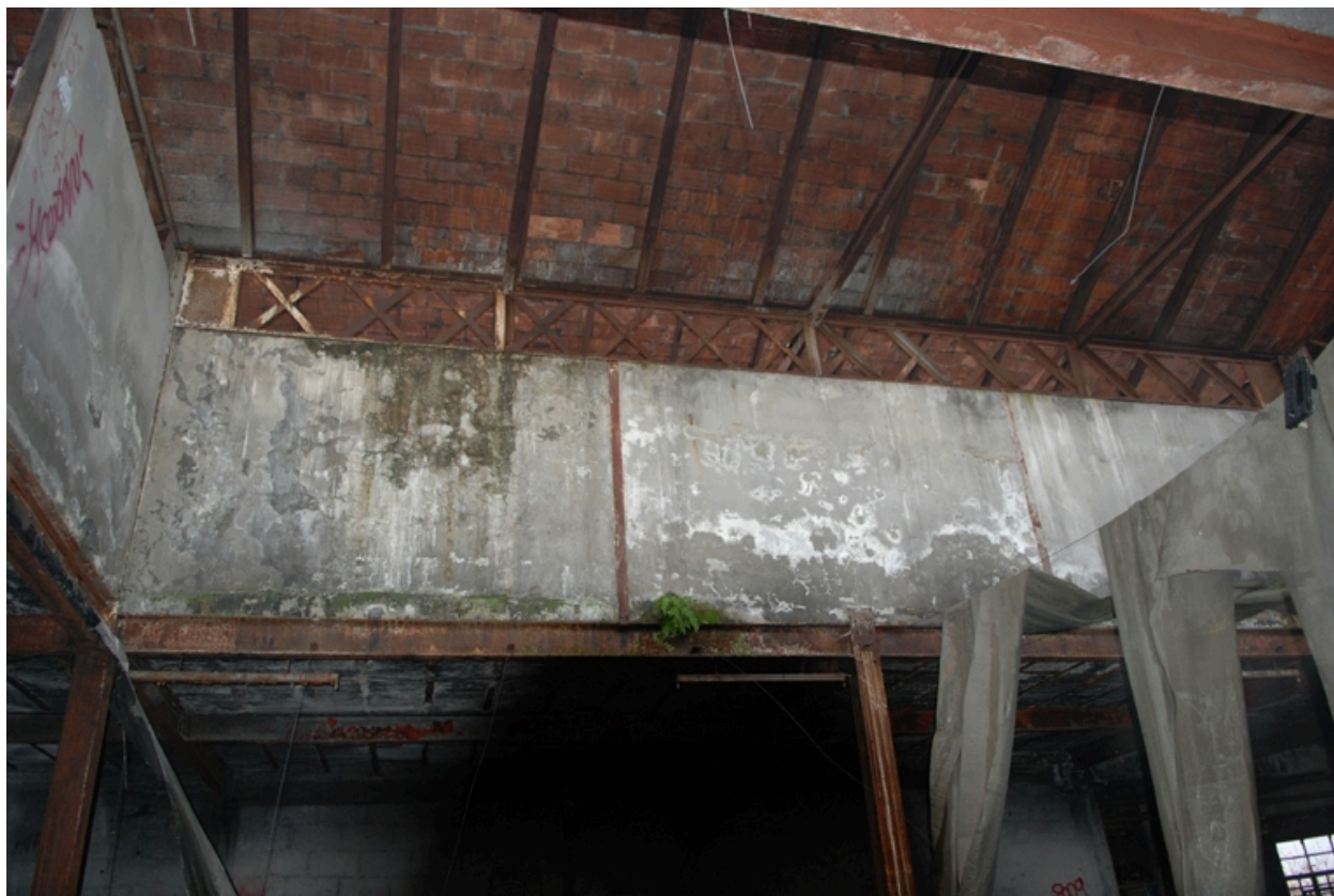
Charpente en hourdis de brique et poutrelles métalliques
