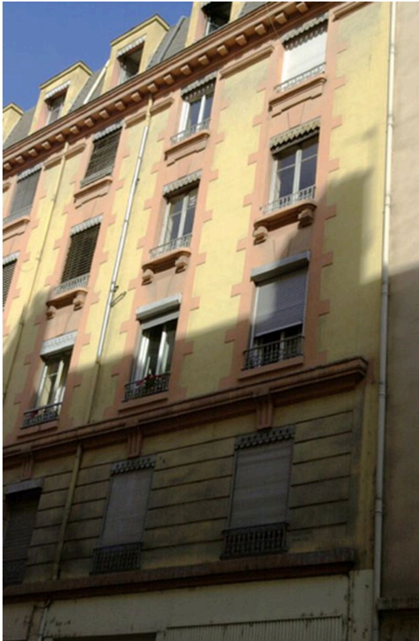
Détail de l'élévation principale
