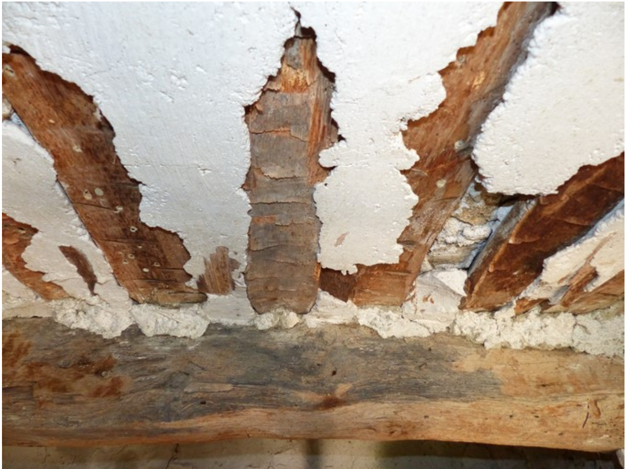
Rez-de-chaussée surélevé. Plafond.
