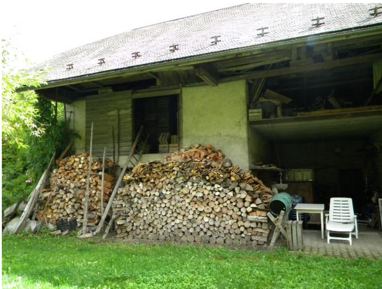
Détail de la façade du bâtiment agricole lié au moulin.
