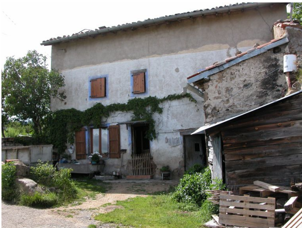
Vue d'ensemble de la façade sur cour.
