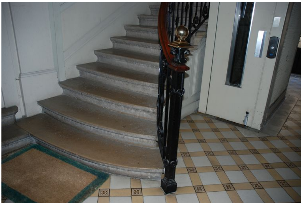
Détail du départ de l'escalier.
