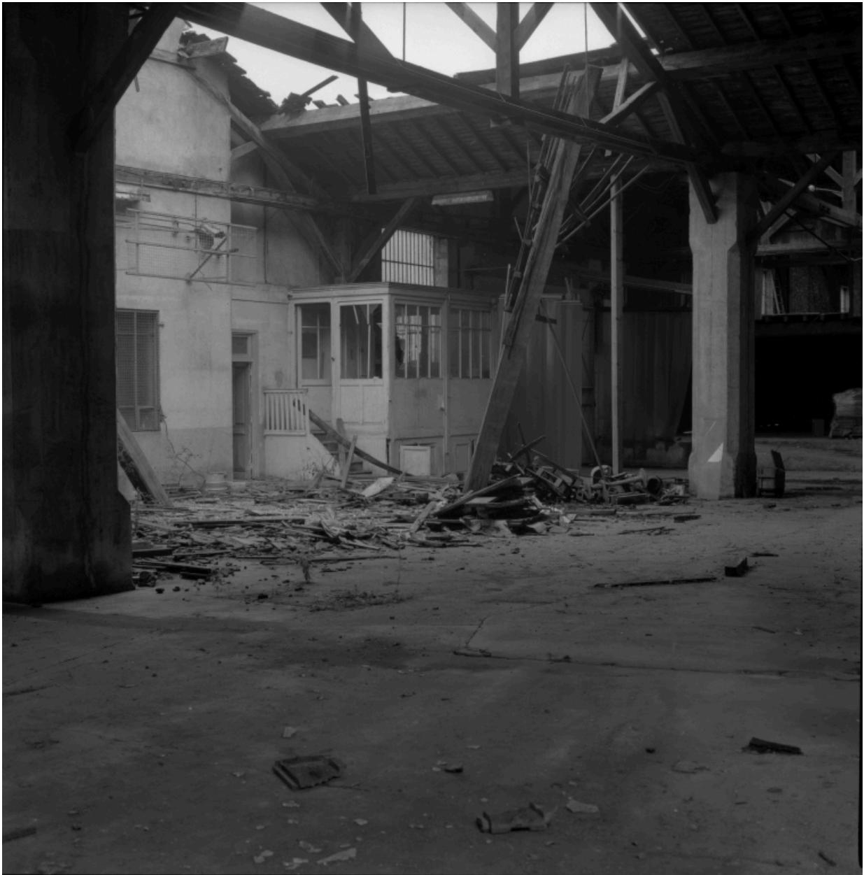
Vue d'ensemble intérieure des bureaux de l'usine de mise en bouteille des eaux minérales.
