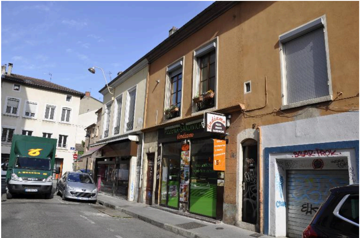
Vue d'ensemble sud est
