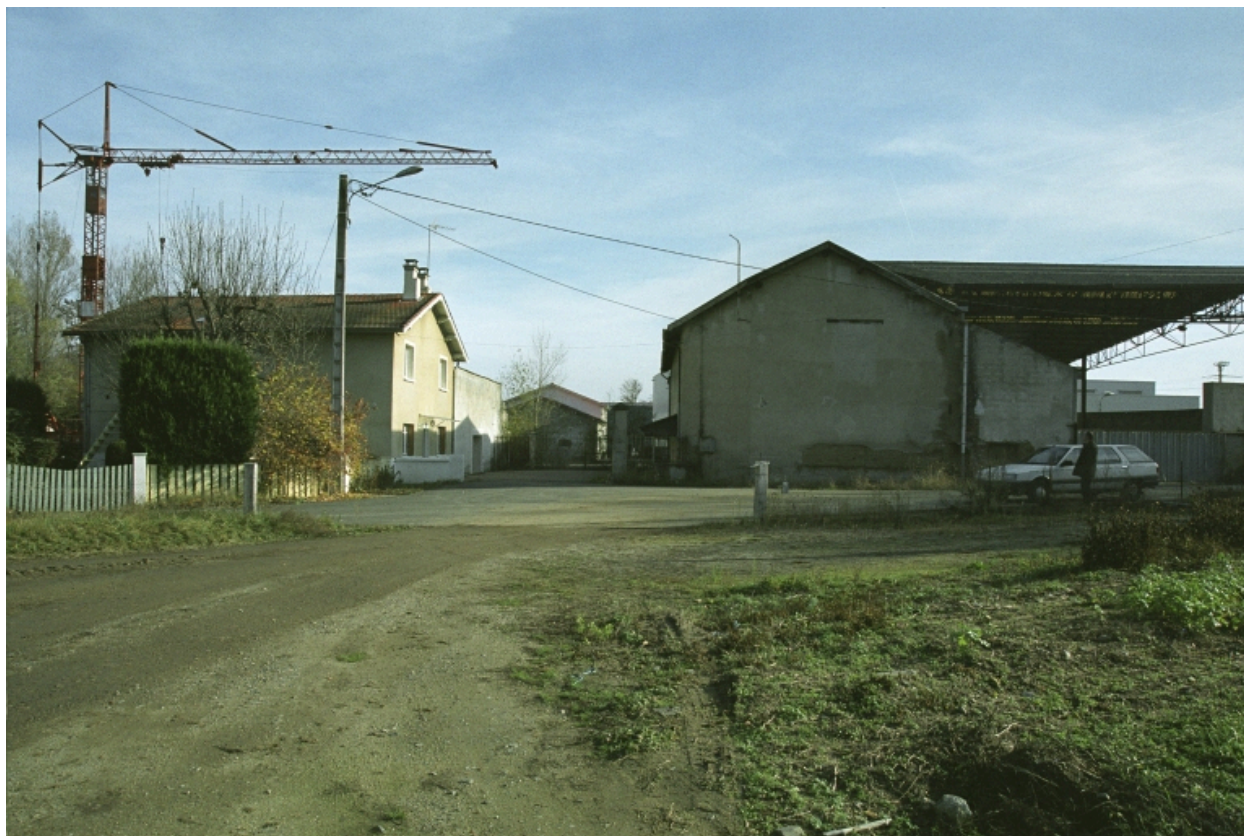
Vue générale de l'ancienne entrée, depuis l'ouest.
