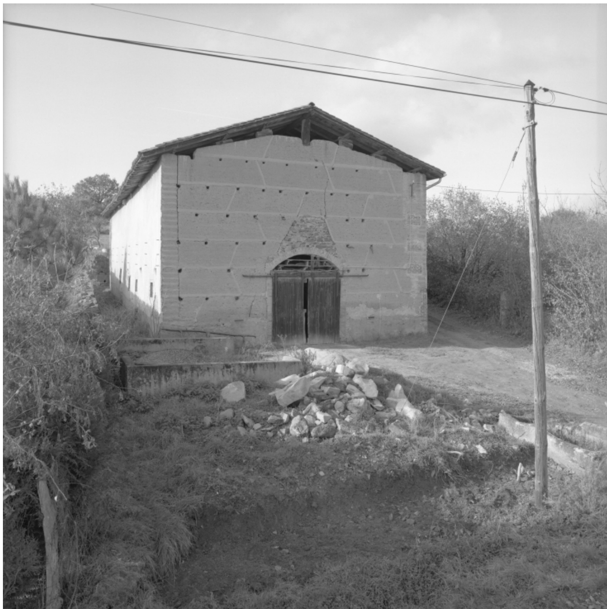
Vue d'ensemble de la grange située de l'autre côté du chemin.
