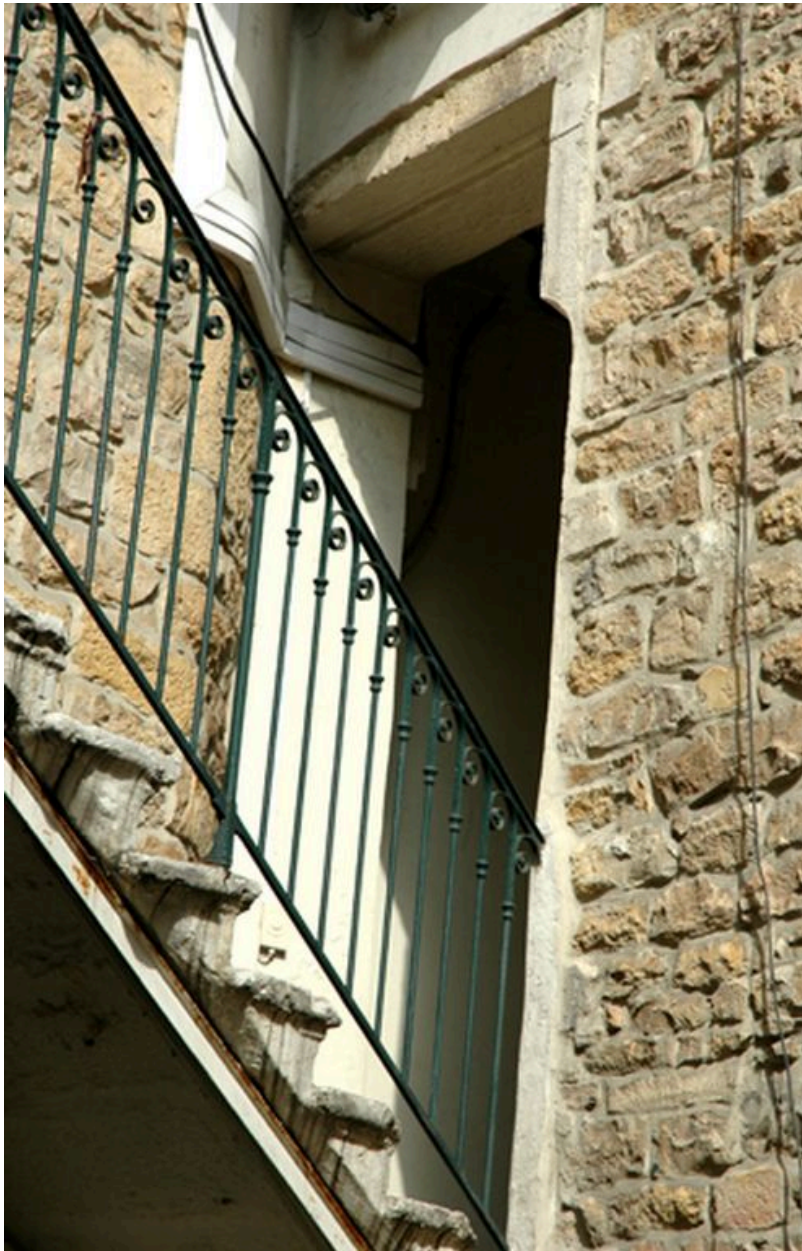
Escalier droit extérieur sur la cour
