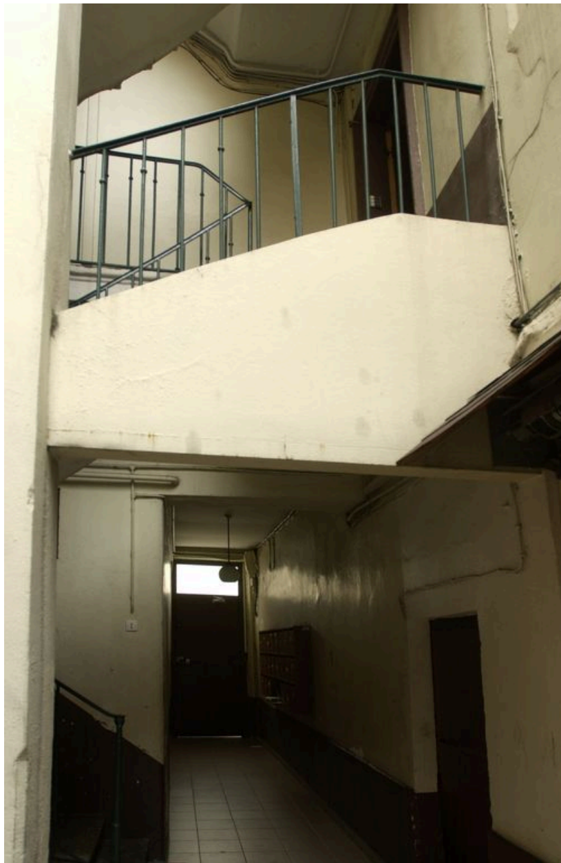
Vue du couloir d'entrée et du passage d'accès au 185 grande rue de la Guillotière
