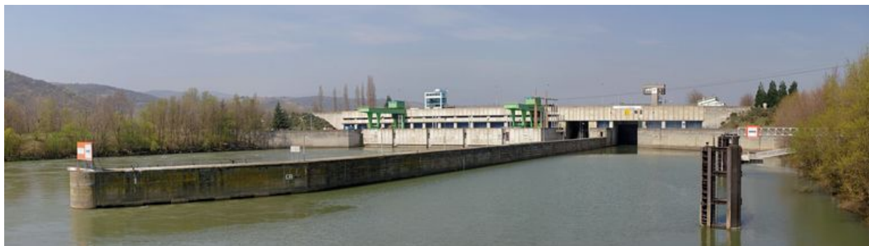
Vue panoramique, côté aval (depuis la rive gauche)
