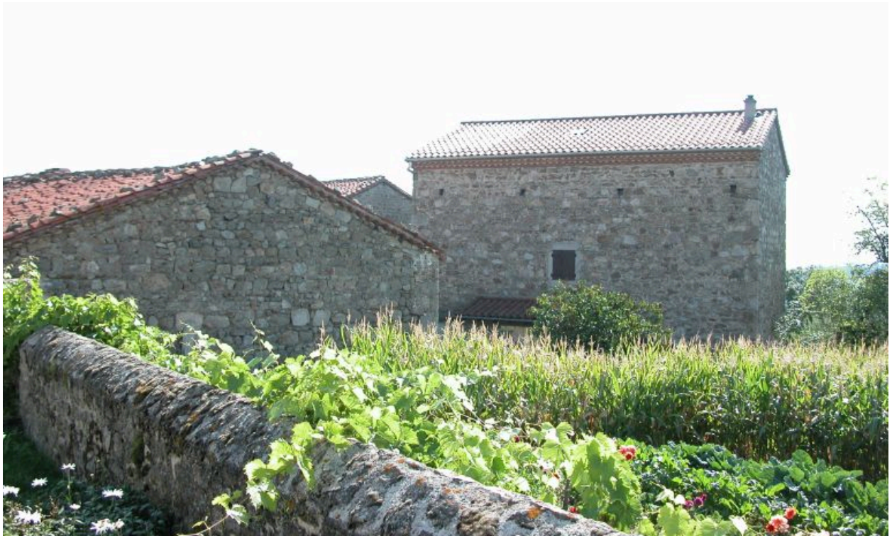
Vue générale de la ferme depuis le nord-ouest.
