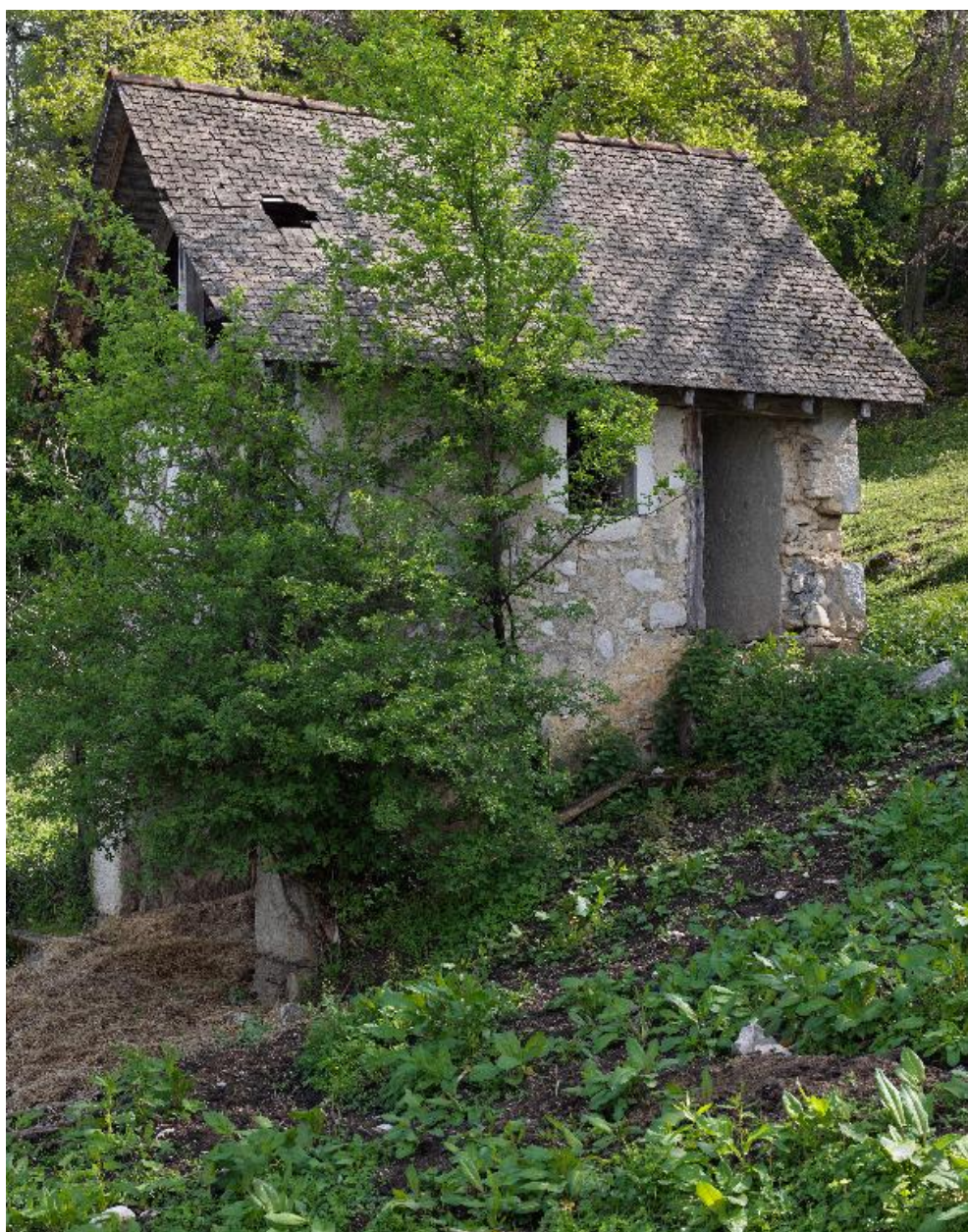
Vue d'ensemble de côté.
