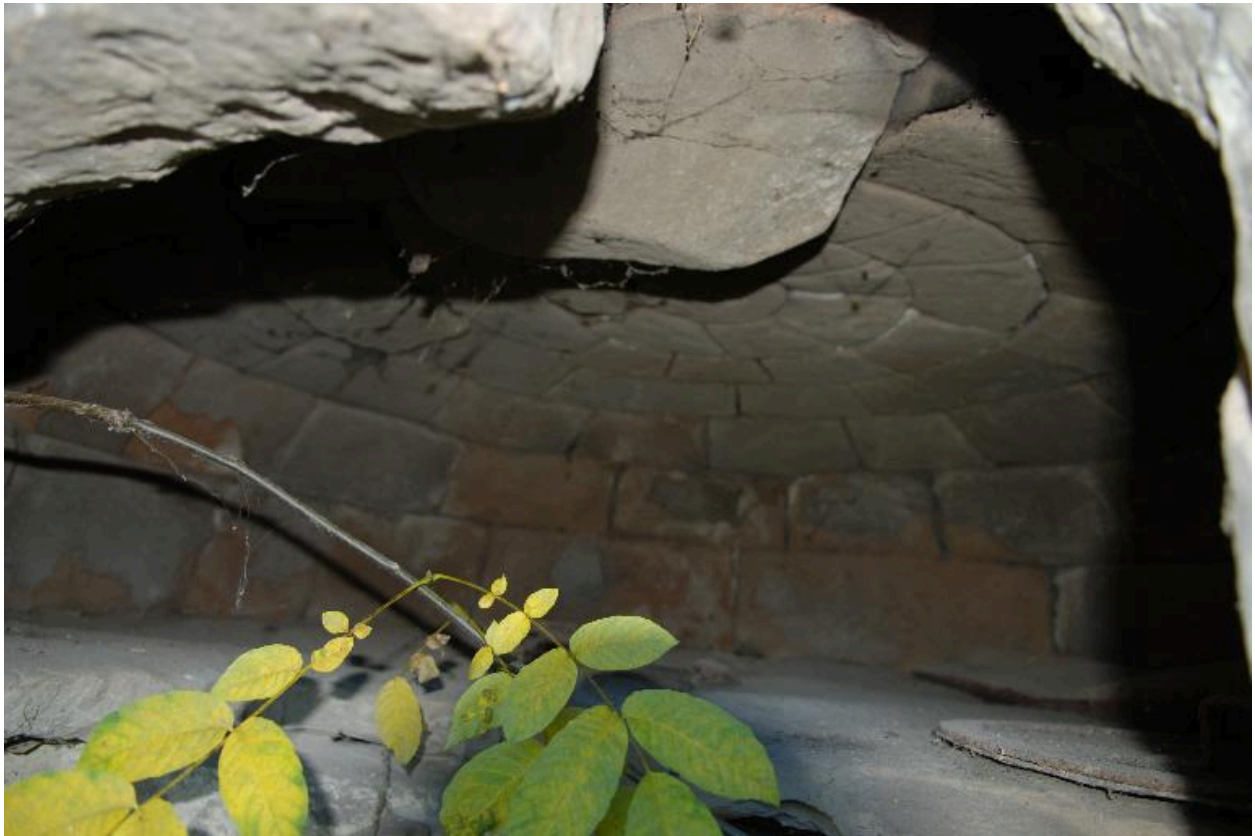
Détail intérieur de la voûte du four à pain.
