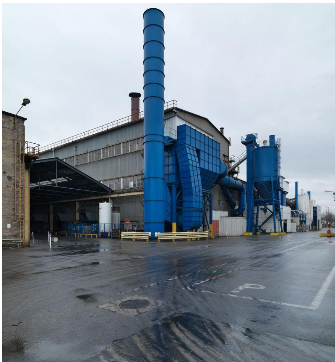
Vue cheminée métallique
