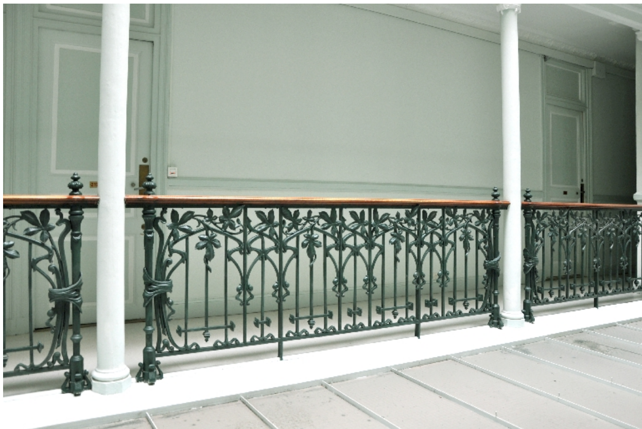
Corps principal : garde-corps de l'atrium, rez-de-chaussée
