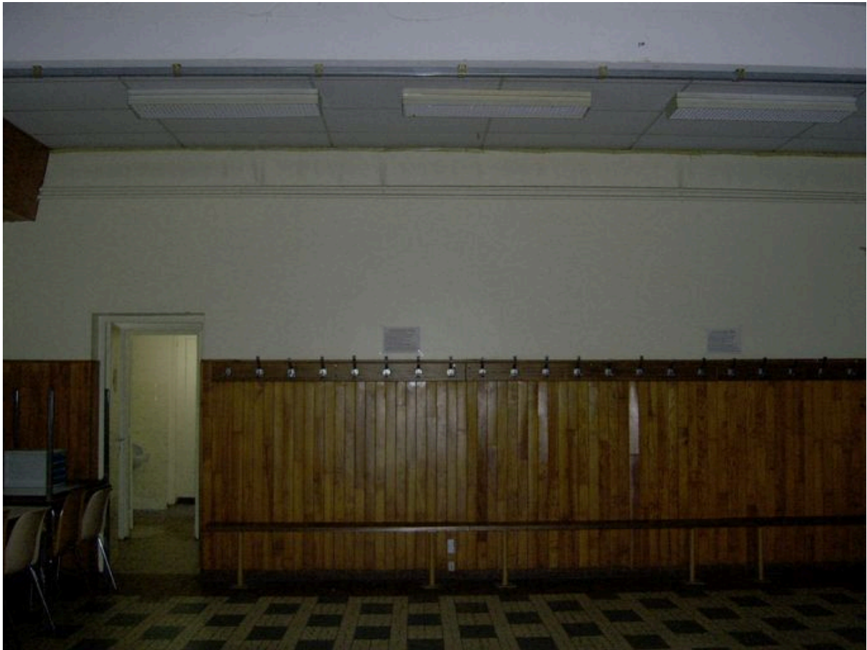
Grande salle en sous sol
