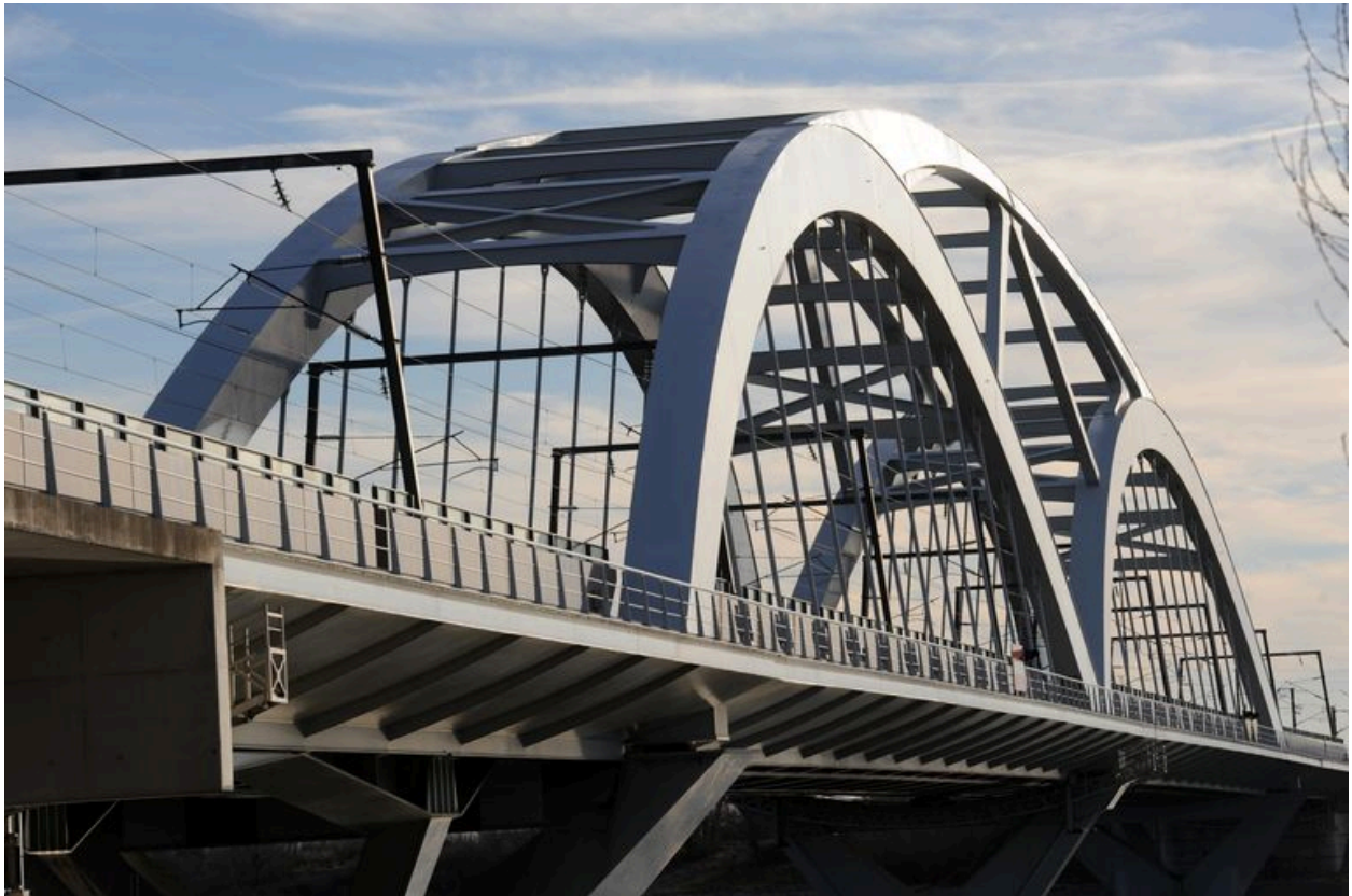
Bow-strings, de côté, face amont, vue générale (depuis la rive gauche)
