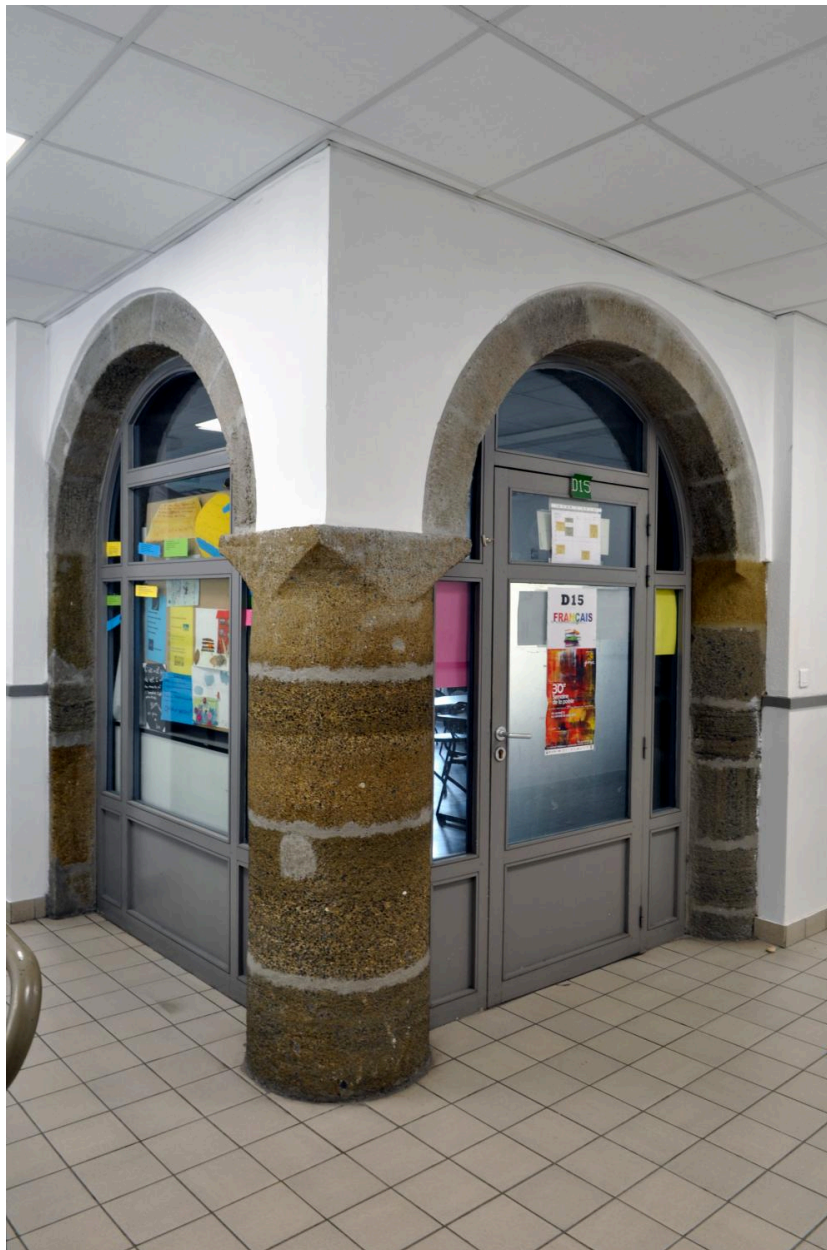
Bâtiment E, rez-de-chaussée : pilier et arcades en plein cintre à l'angle ouest du couloir
