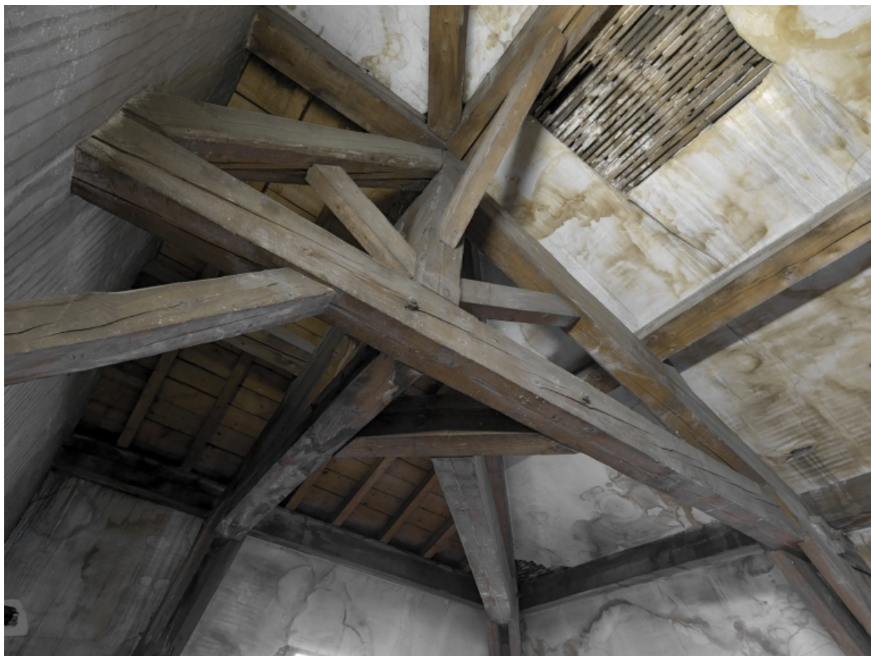
Bâtiment C. Charpente du corps de bâtiment côté sud
