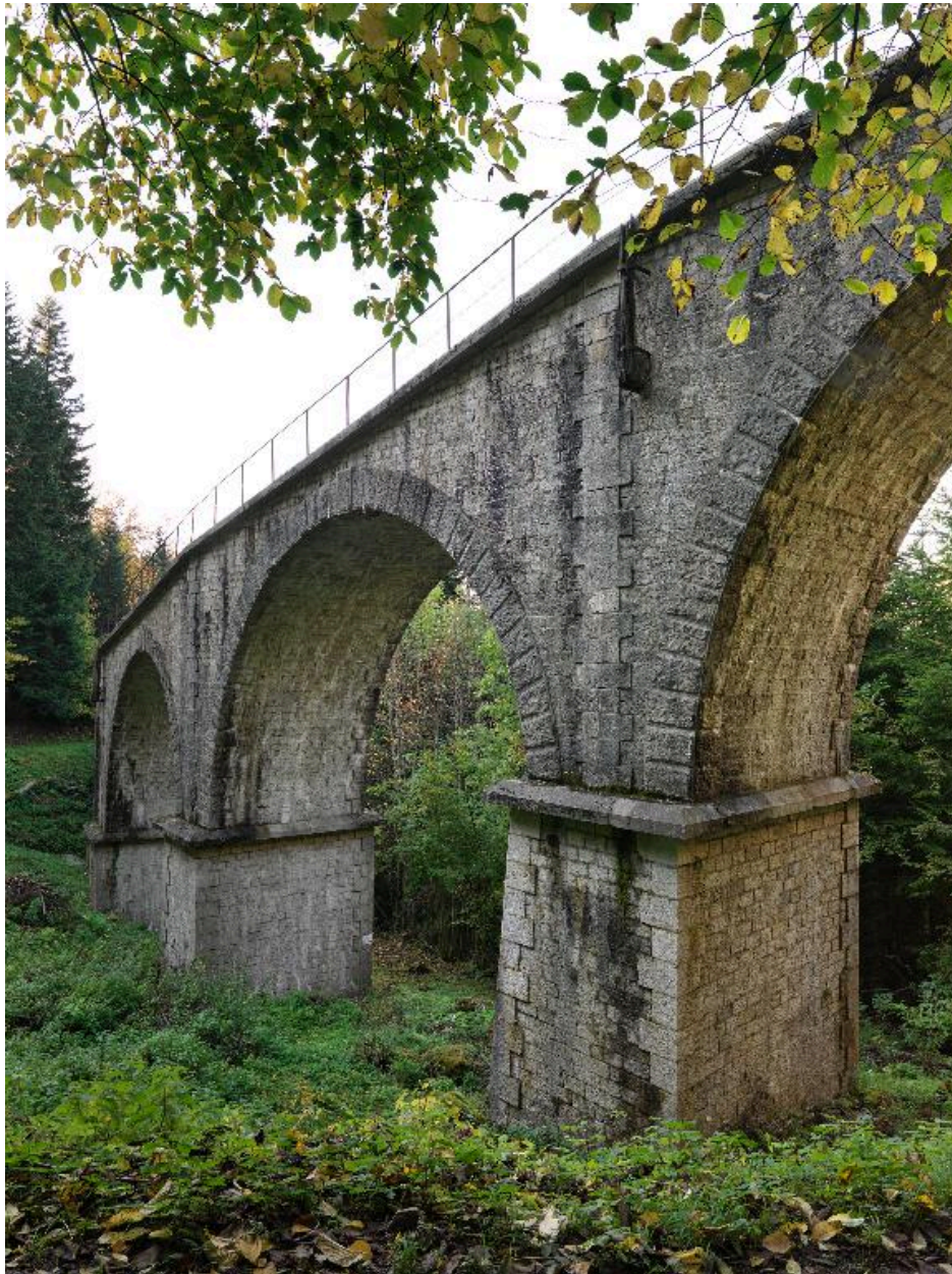
Viaduc des Fontanettes : arches.
