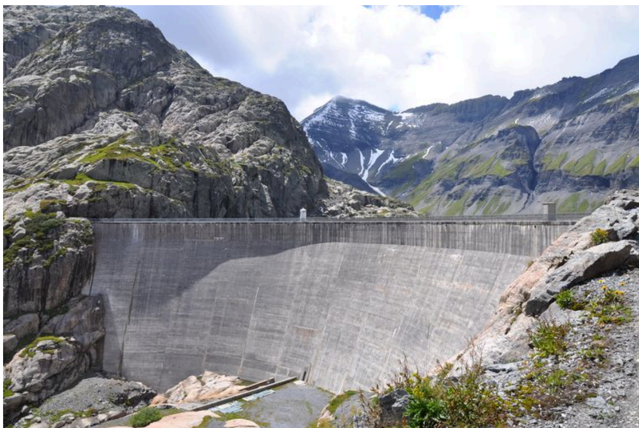
Barrage du Vieux-Emosson
