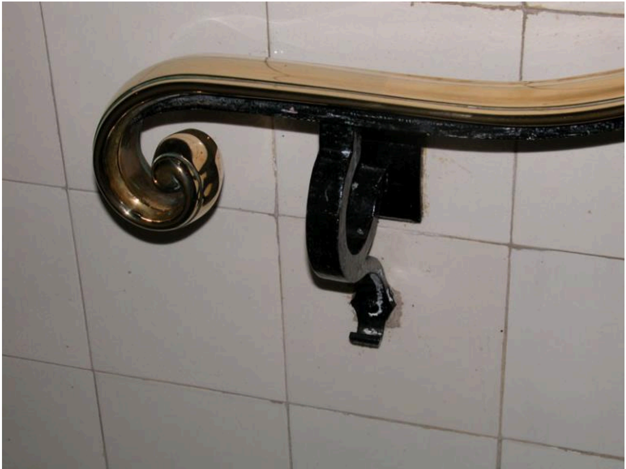
Détail de l'extrémité d'une main courante, dans l'un des escaliers desservant le 1er étage de soubassement (photographie chercheur).
