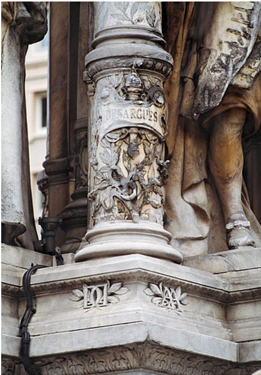
Détail de la partie inférieure des colonnes
