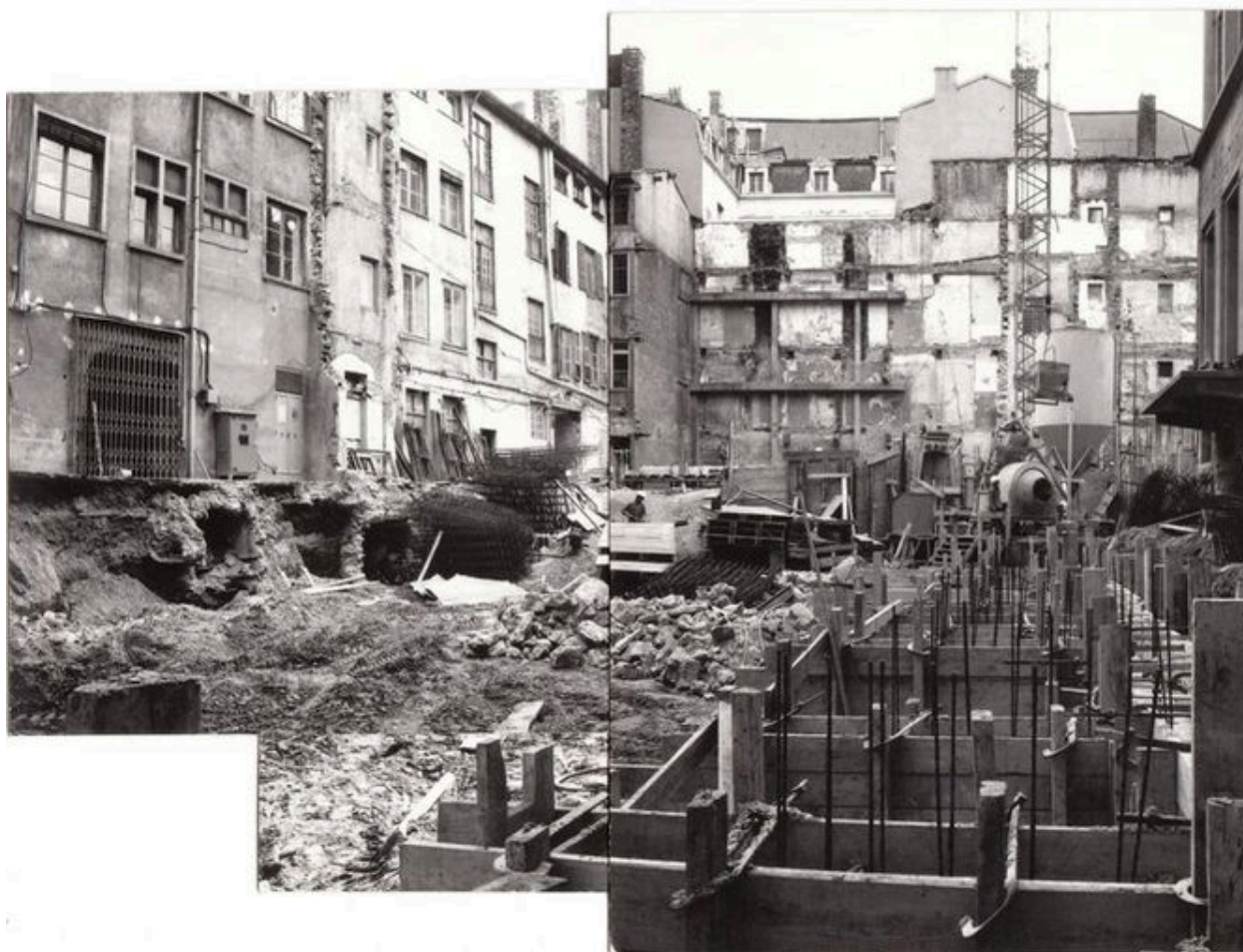
Chantier du bâtiment ISARA (2nd phase), montage de trois photographie anciennes, 1972
